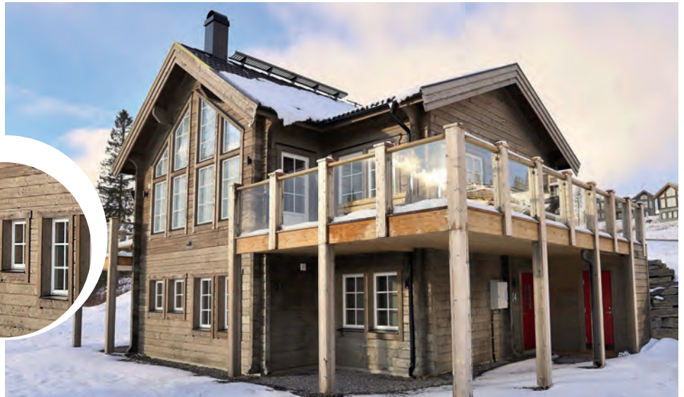
Souterränghus med timmerbeklädnad samt knutar, foder och salning för concellvägg (prefab betong). Bild: @skistar
